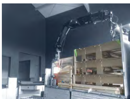
Abladung und Montage des Verladehubtisches
