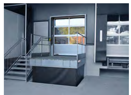
Hubtisch mit PVC-Rollos und Geländer, Speziallackierung für Außenbereich Nutzlast: 2.000 kg | Nutzhub: 1.500 mm
