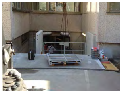
Hubtisch Montage mit Kran
